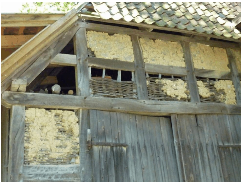
Das Foto zeigt den ursprünglichen Aufbau einer inzwischen verfallenden Scheune als Fachwerkgebäude.
